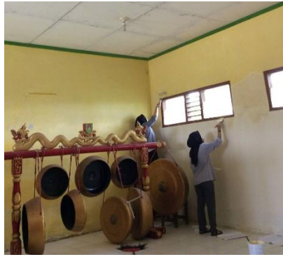
Gambar 4 Pengecatan Tembok Ruang Baca
